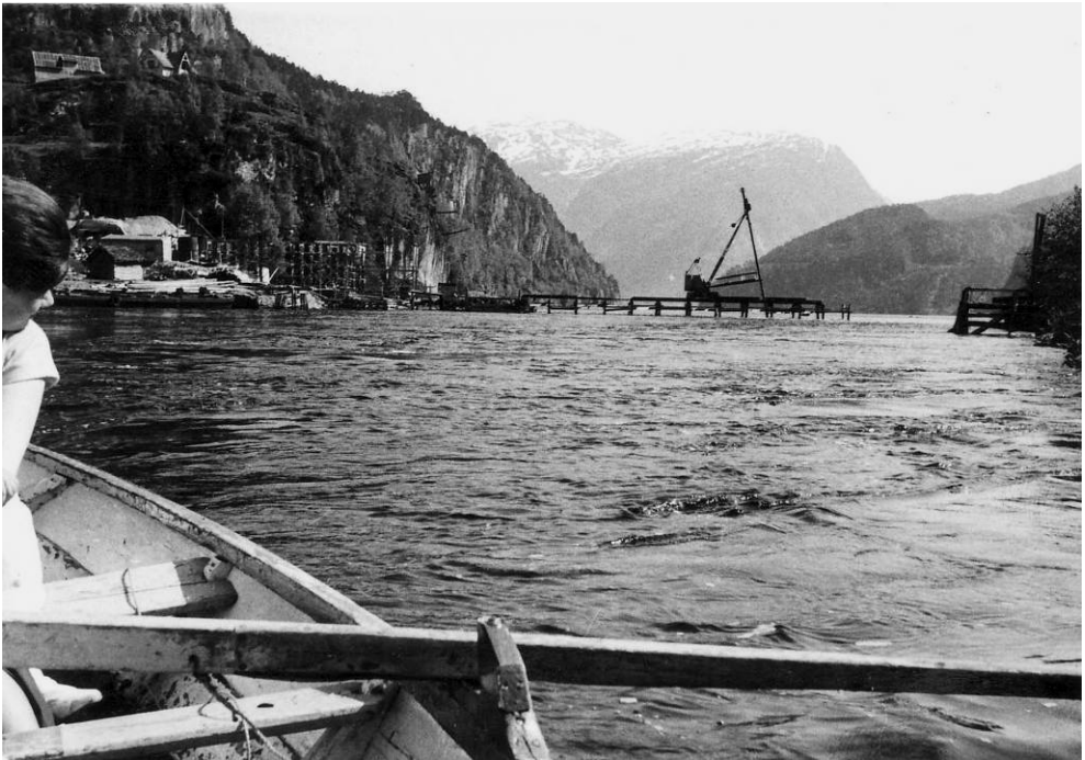
Arbeidet med pæling av brua er godt i gang. I venstre bilekant ser ein Bjørg på ro tur i straumen.
