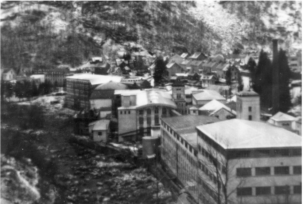
Dale i slutten av 30-åra. Gamleheimen er til høyre i bildet.
